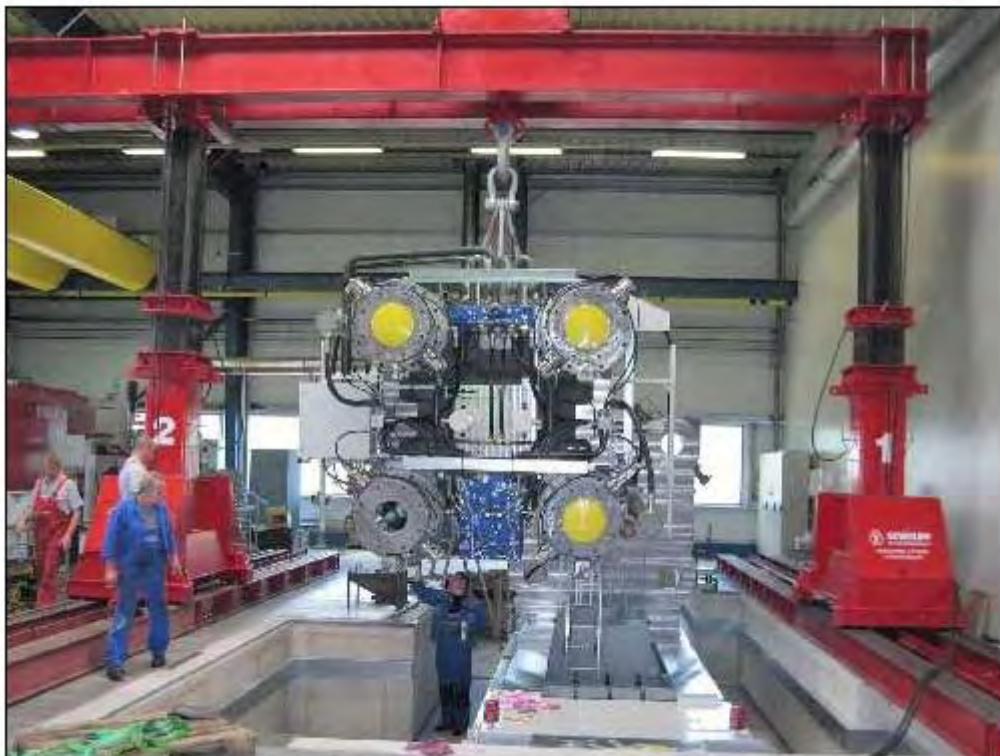
Millimeter genau werden die Teile in die Grube gesetzt.
