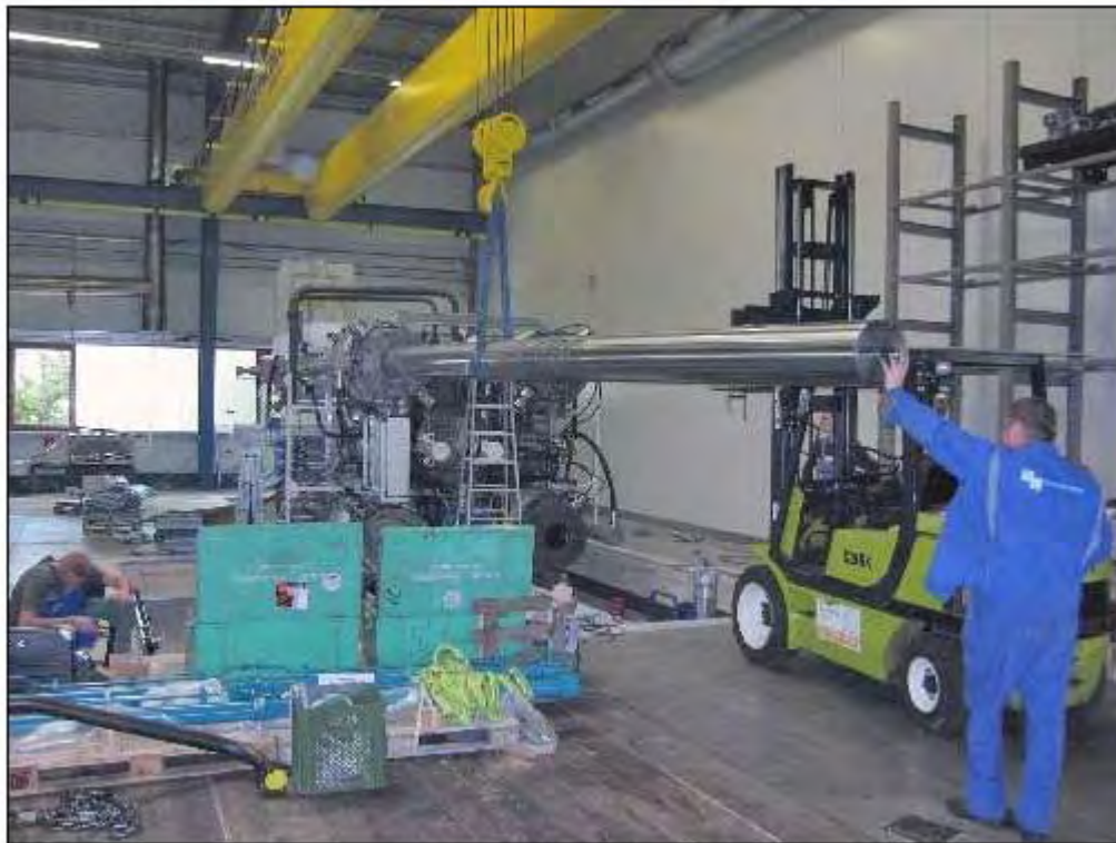
Der Einbau der letzten Säule.
